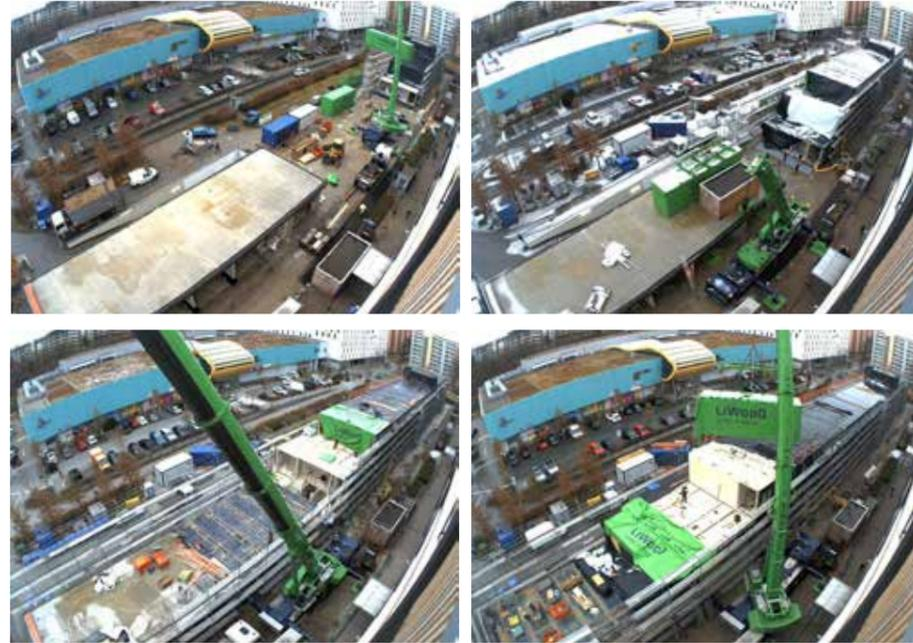
Zwischen Dezember und Februar wurden auf der Baustelle 140 Module gesetzt; der Rohbau fand somit komplett in den Wintermonaten statt. Lediglich sechs Wochen nahm hierbei das Stellen der Module in Anspruch. Der Innenausbau sowie die Fassadenarbeiten werden bis zur Jahresmitte 2022 und somit zum Beginn des neuen Schuljahres komplett fertiggestellt sein.
